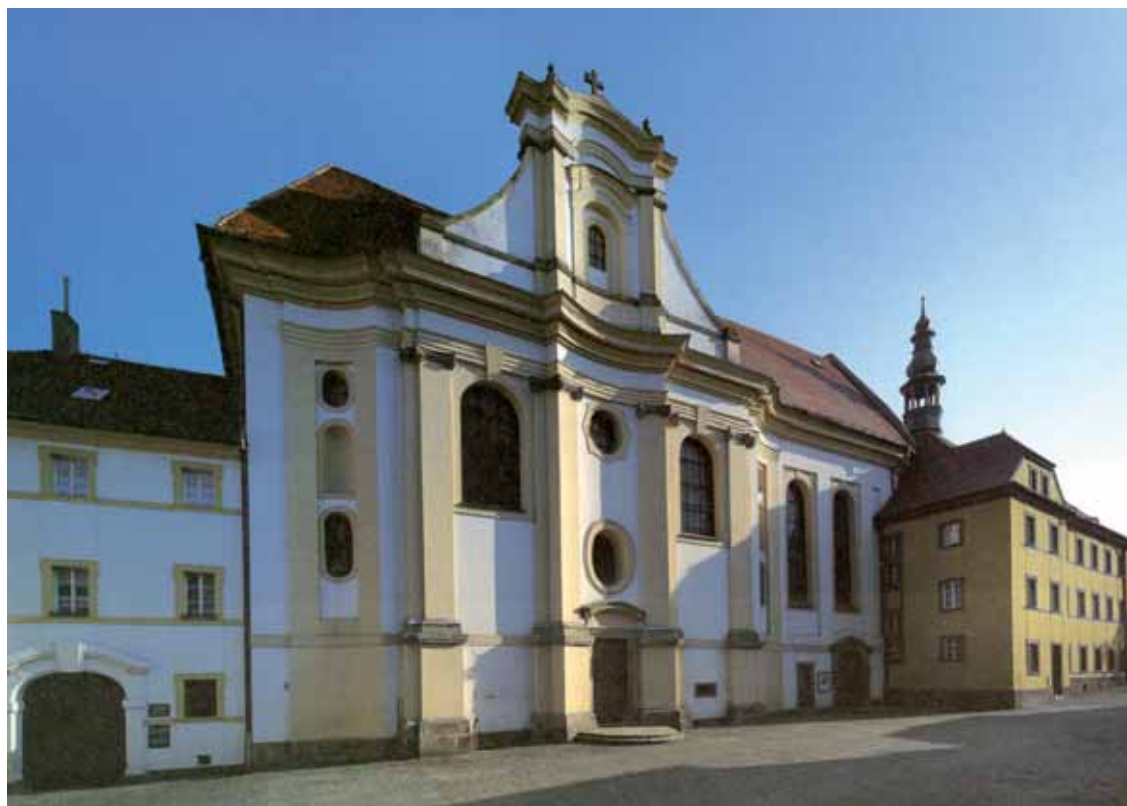
18. Kryštof Dientzenhofer, kostel sv. Kláry v Chebu, 1707–1711, průčelí. Foto Jaroslav Kučera.
