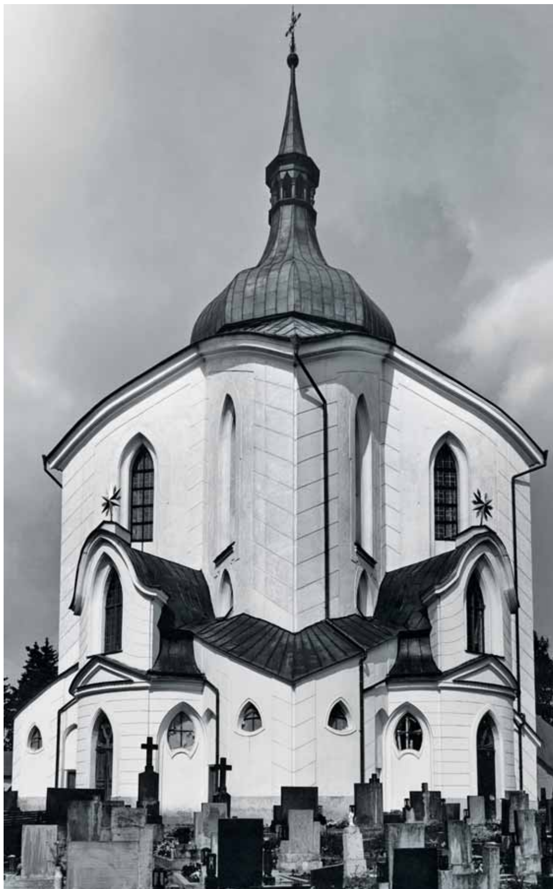
25. Jan Blažej Santini-Aichel, poutní kostel sv. Jana Nepomuckého na Zelené hoře ve Žďáru nad Sázavou, 1719–1722, exteriér. Foto Vladimír Uher.
